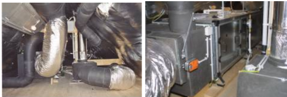
Légkezelő gép a tetőtérben
