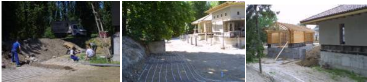
Földabszorber csövek elhelyezése az épület körül
