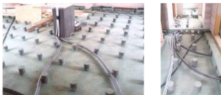
Vízszintes légcsatorna kialakítása (a végleges padló szerkezet a képen látható betontuskókra van helyezve)
