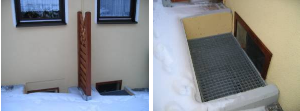
A géphez vezető levegő be- és kifújását biztosító szellőzőrács
